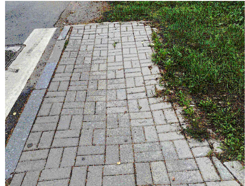
Существующая раскладка плитки
